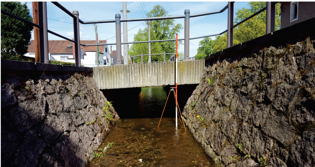
Abbildung 6.4: Grundstückszufahrt der Brücke Nr. 5 bei Lotzebach-km 2+329
