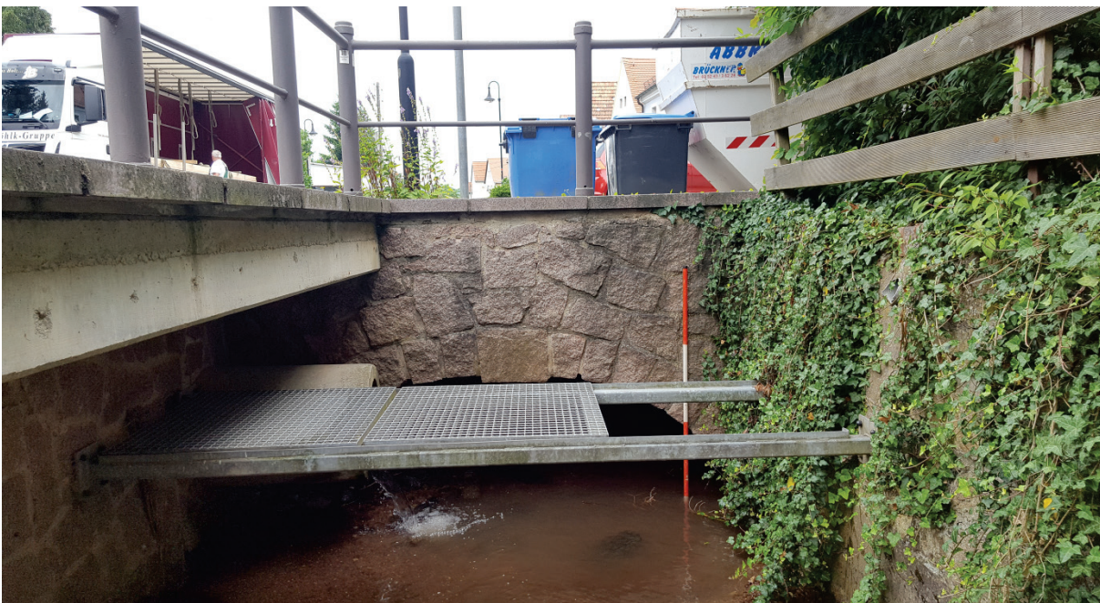
Abbildung 7.16: Einlauf der Talstraßenverrohrung bei Lotzebach bei km 2+610
