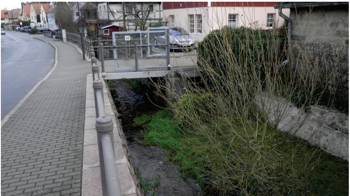
Abbildung 7.18: Lotzebach bei km 2+660 mit Blick nach unterstrom auf die Brücke Nr. 11
