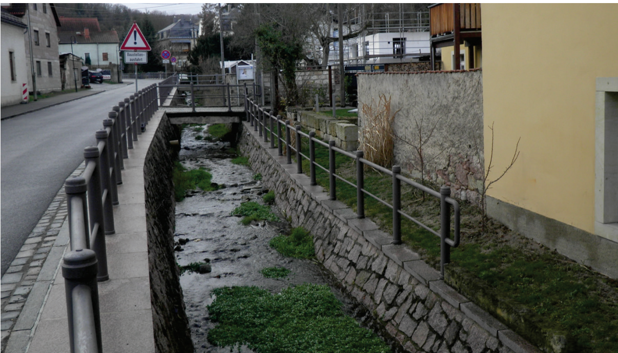
Abbildung 7.11: Lotzebach bei km 2+370 mit Blick nach oberstrom auf die Brücke Nr. 6
