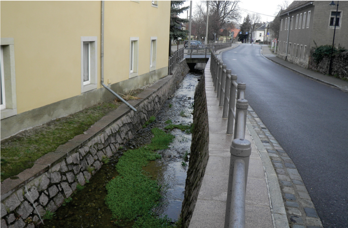
Abbildung 7.10: Lotzebach bei km 2+370 mit Blick nach unterstrom auf die Brücke Nr. 5
