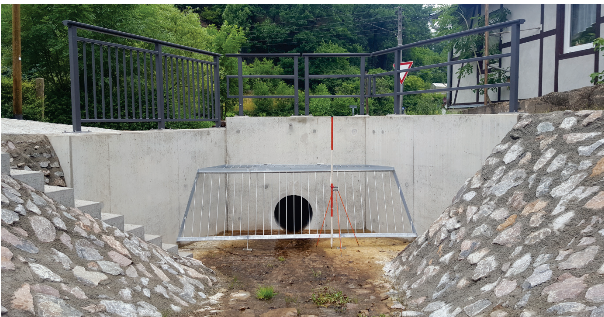
Abbildung 6.8: Einlauf des verrohrten Mündungsabschnitts (Brücke Nr. 1) im Rauschebach
