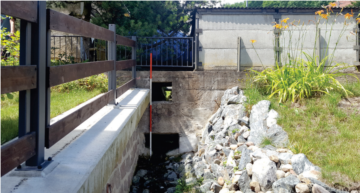
Abbildung 6.7: Auslauf der Brücke Nr. 3 bei km 0+093 im Hässiger Bach
