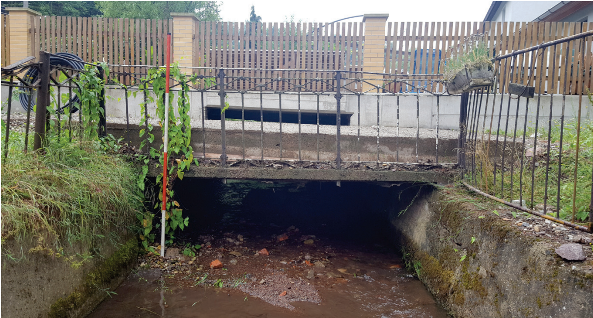
Abbildung 6.2: Ausläufe der Brücken Nr. 20 (Hintergrund) und Nr. 19 bei Lotzebach-km 3+058
