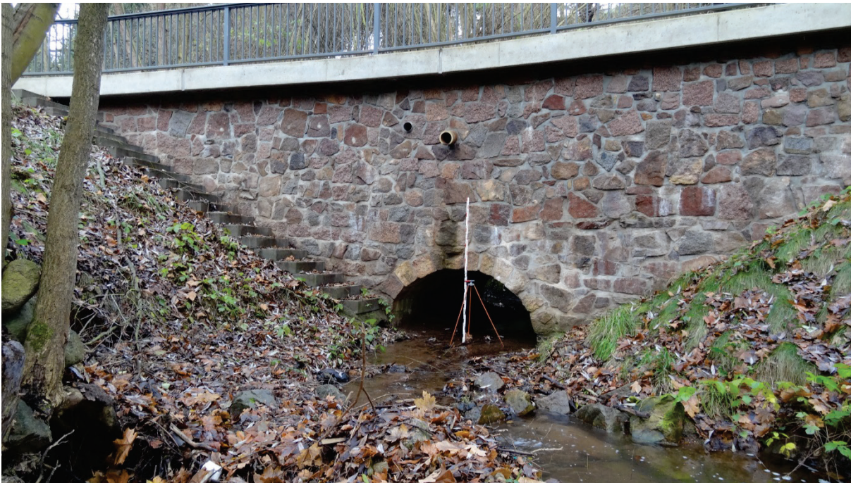
Abbildung 6.10: Auslauf der Brücke Nr. 5 im Zuge der Tännichtgrundstraße
