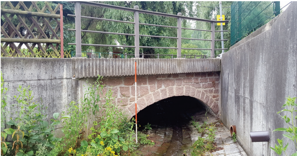
Abbildung 6.1: Einlauf der Brücke Nr. 23 im Zuge der Talstraße bei Lotzebach-km 3+156
