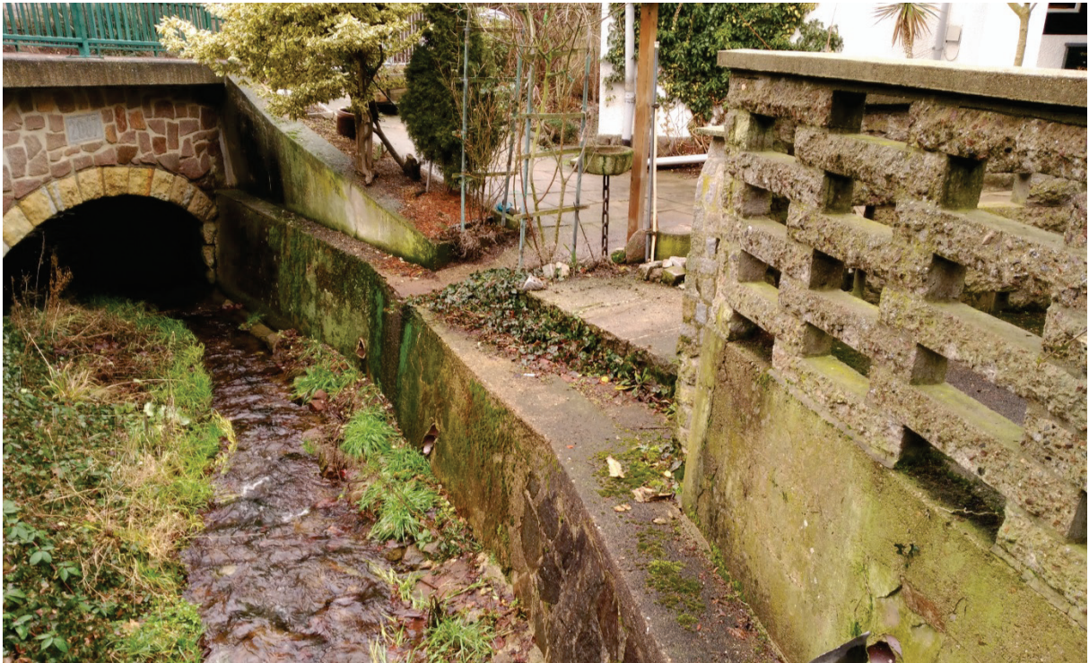
Abbildung 7.29: Blick von der Brücke Nr. 33 bei Lotzebach-km 3+655 auf den Einlauf der Brücke Nr. 32, Talstraße 97 rechts im Bild
