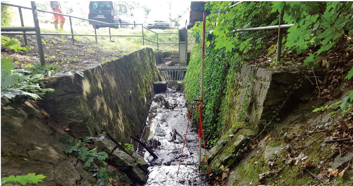
Abbildung 6.9: Einlauf des verrohrten Mündungsabschnitts im Amselgrundbach
