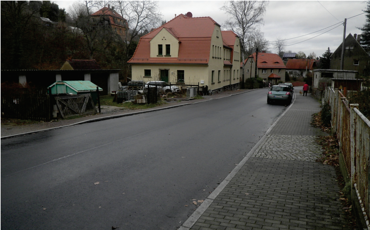
Abbildung 7.22: Blick auf die Talstraße in Höhe von ca. Lotzebach-km 3+000 nach stromab
