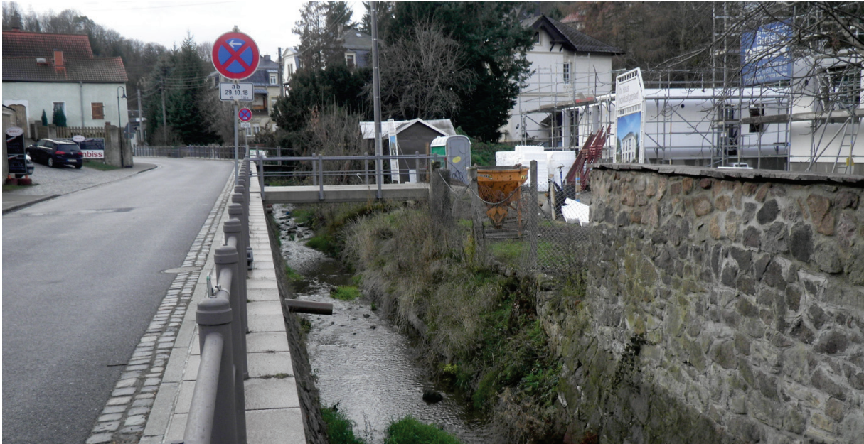
Abbildung 7.12: Lotzebach bei km 2+400 mit Blick nach oberstrom auf die Brücke Nr. 6a
