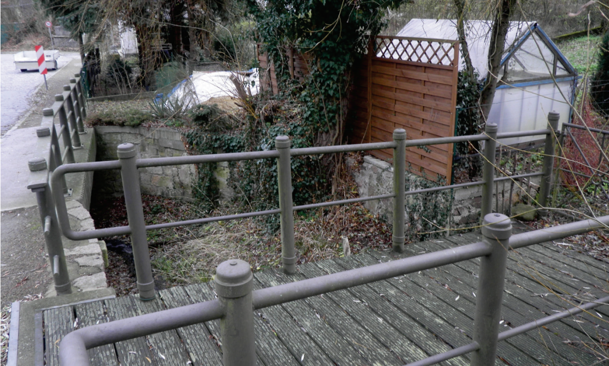
Abbildung 7.28: Blick von der Brücke Nr. 24 bei Lotzebach-km 3+170 auf den Einlauf der Brücke Nr. 23, Talstraße links im Bild
