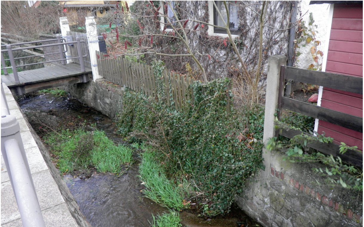
Abbildung 7.17: Lotzebach bei km 2+630 mit Blick nach unterstrom auf die Brücke Nr. 10
