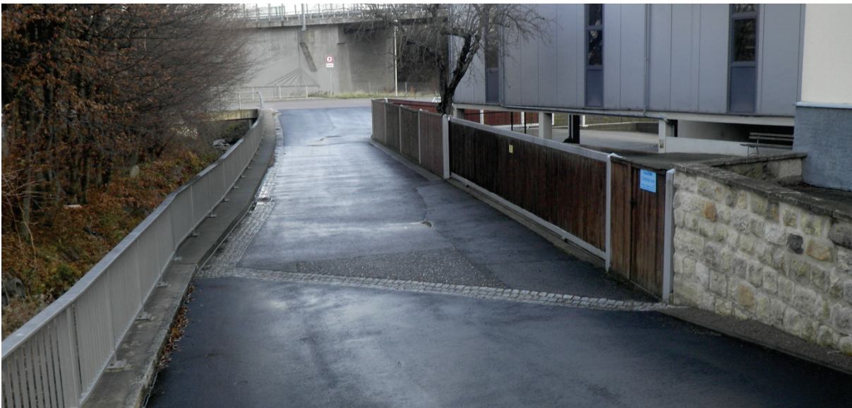
Abbildung 7.30: Blick von der Meißner Straße auf das rechte Ufer des Tännichtgrundbachs im Mai 2014 (oben) bzw. im Dezember 2018 (unten), moeni TEC GmbH rechts im Bild
